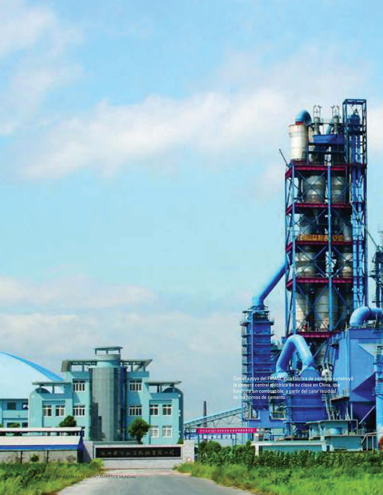
Con el apoyo del FMAM, esta fábrica de cemento construyó la primera central eléctrica de su clase en China, que funciona sin combustible, a partir del calor residual de los hornos de cemento.
